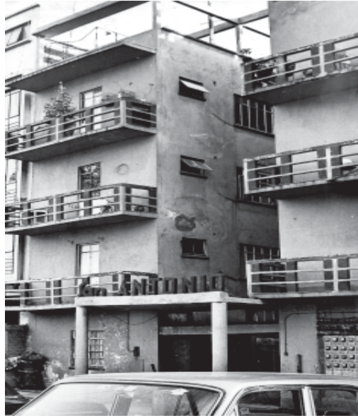
Edificio San Antonio, en Chapultepec no. 512, Ciudad México.
